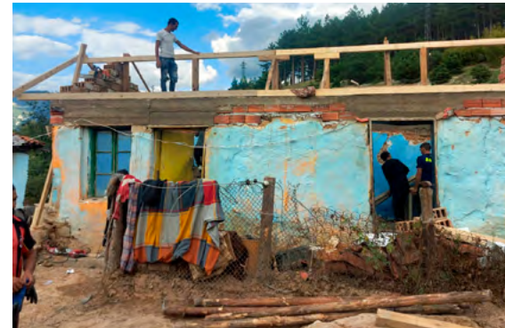
Ett nytt tak byggdes på huset för att ersätta det kollapsade.
